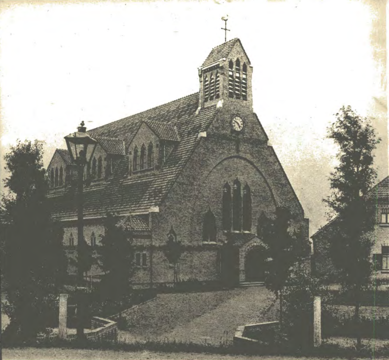
ÉGLISE DE NOORDHOEK (Hollande) Vue extérieure
