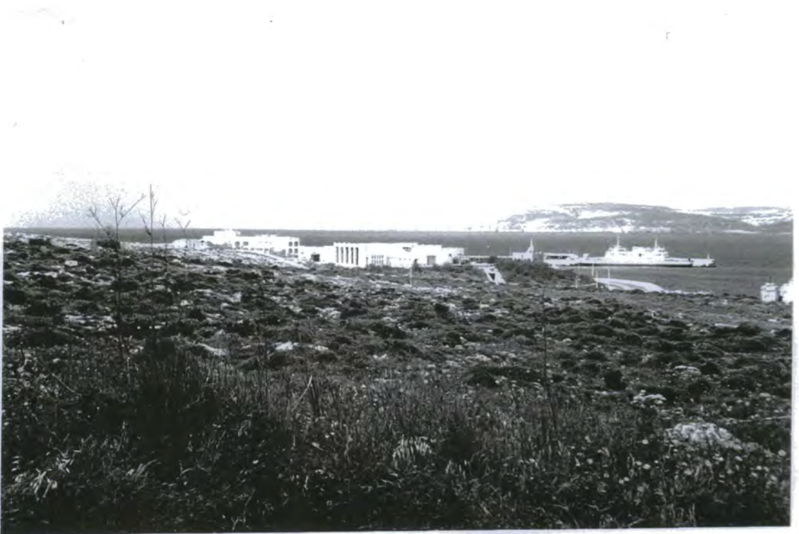
Plate 3.2. The Cirkezza RO plant.
