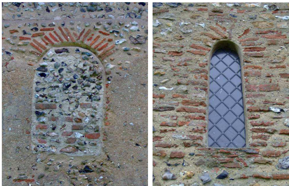
Figures 15 et 16 : Position non-radiale des claveaux de briques dans les arcs des fenêtres anglo-saxonnes : à gauche : église St Mary-the-Virgin, Houghton-on-the-Hill, Norfolk ; à droite : église St Mary and All Saints, Rivenhall, Essex.
