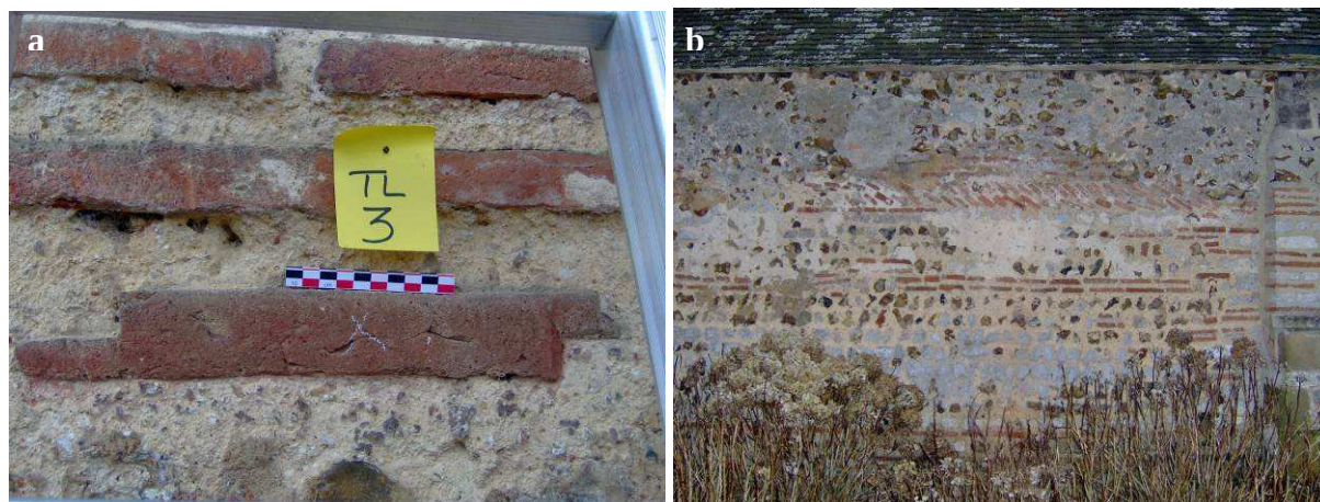
Figures 73 a & b : Tegula entière réemployée dans la maçonnerie du mur nord de la nef ; opus spicatum dans la partie supérieure du mur nord de la nef.
