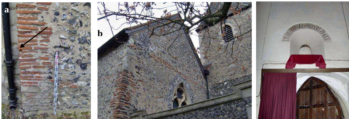
Figures 137 a, b & 138 : Chaînage d'angle du mur nord de la nef -la flèche indique la brique prélevée- ; pan du mur occidental et vue de l'intérieur de la fenêtre anglo-saxonne
